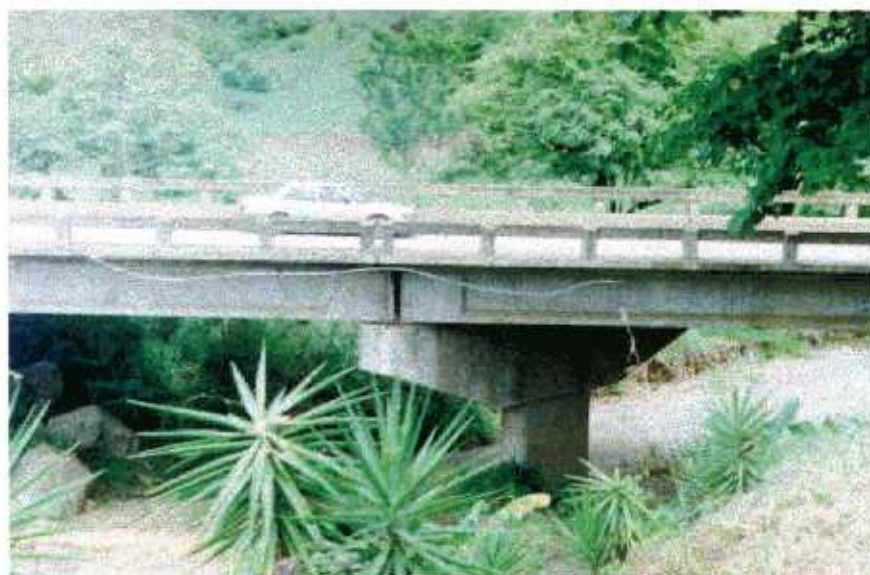
Fig. F-2: Puente sobre el Río La Mona
