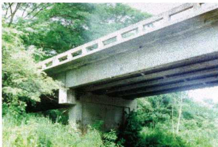
Fig. F-4: Puente sobre el Río Tarcolitos
