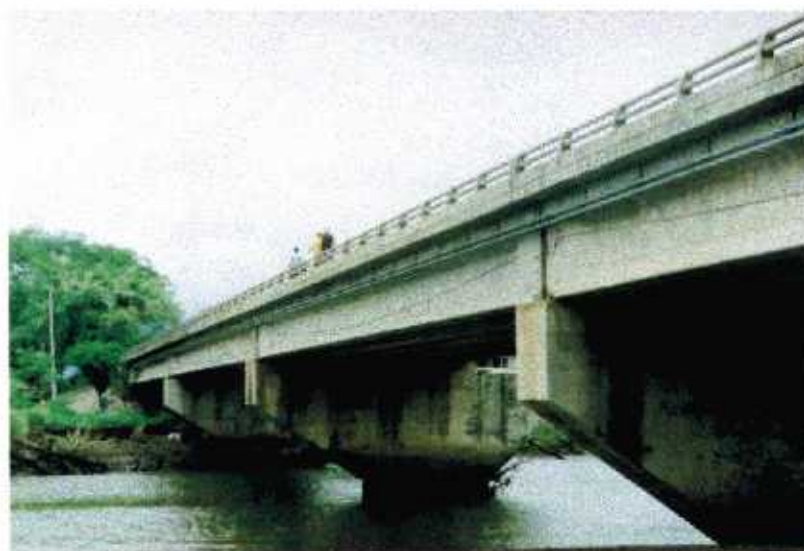
Fig. F-8: Puente sobre el Río Barranca (Ruta 23)
