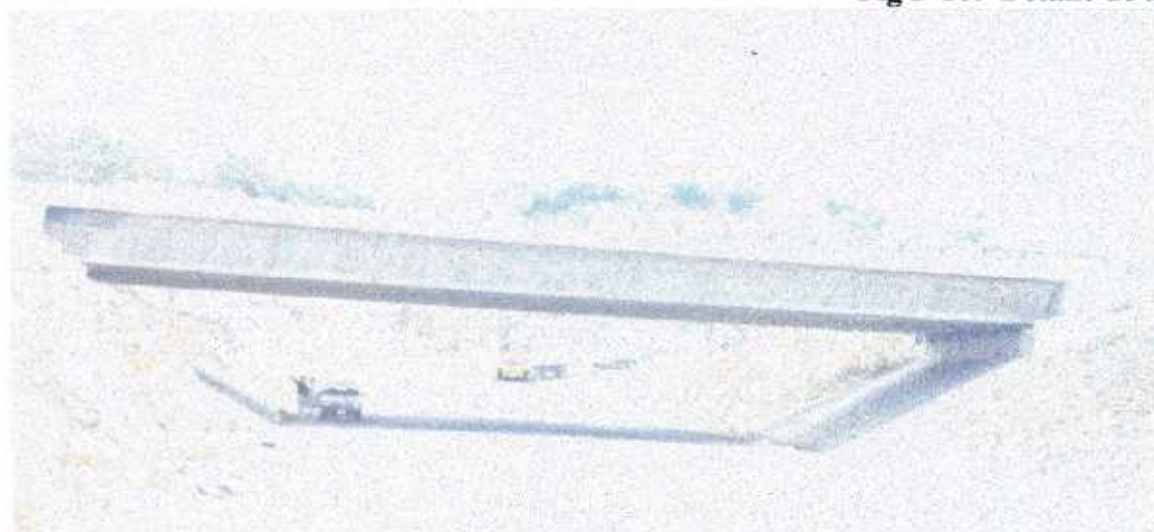
Fig F-11: Paso a desnivel sobre la ruta 32
