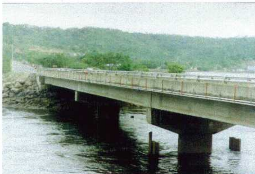
Fig. F-7: Puente sobre el Estero Mata de Limón
