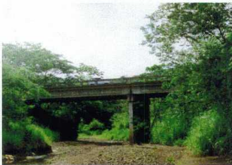
Fig. F-3: Puente sobre el Río Agujas
