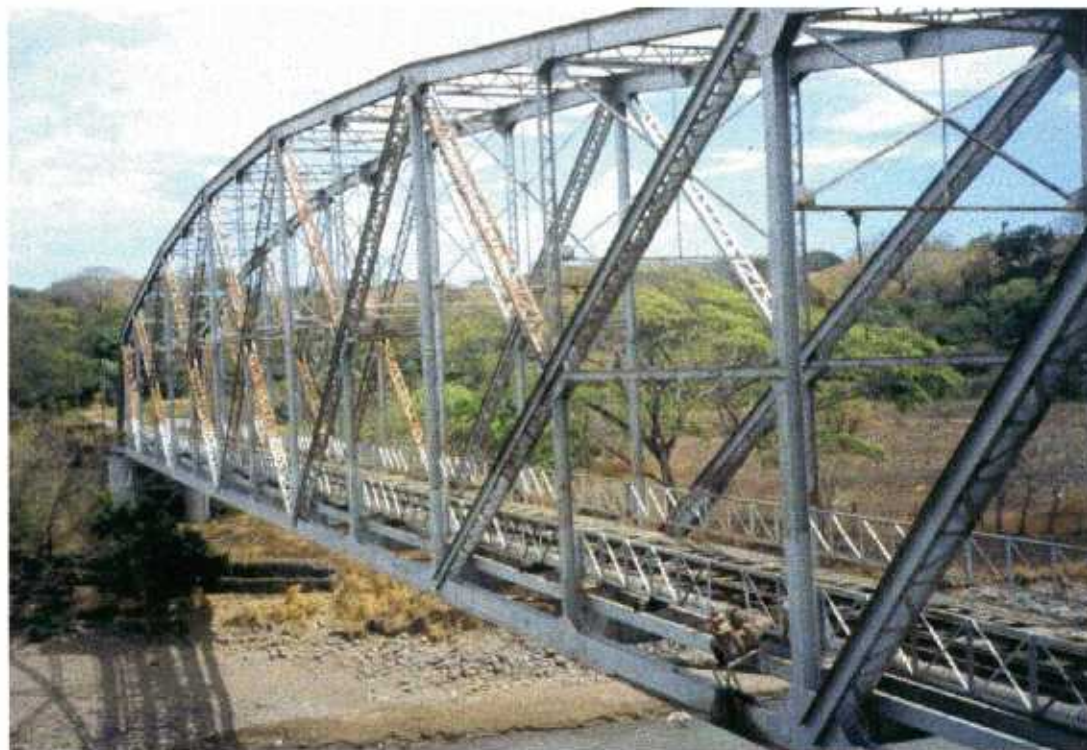
Fig F-13: Puente ferroviario sobre el Río Barranca
