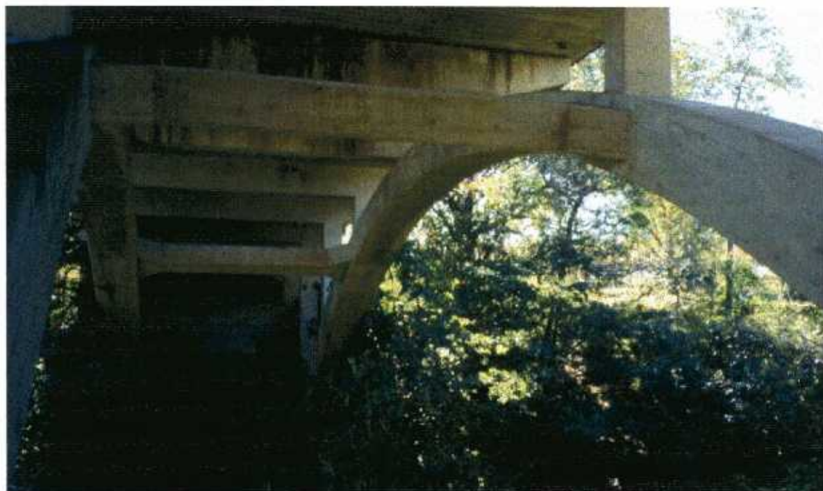
Fig F-29: Puente sobre el Río El Salto.
