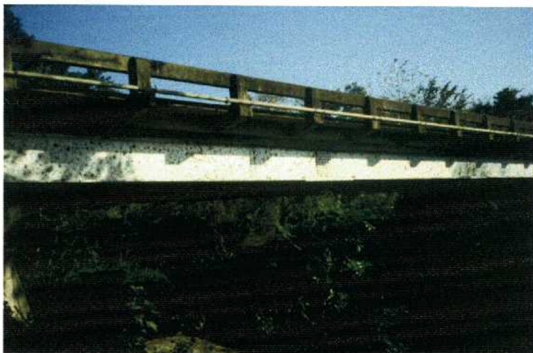
Fig. F-31: Puente sobre el Río Santa Inés.
