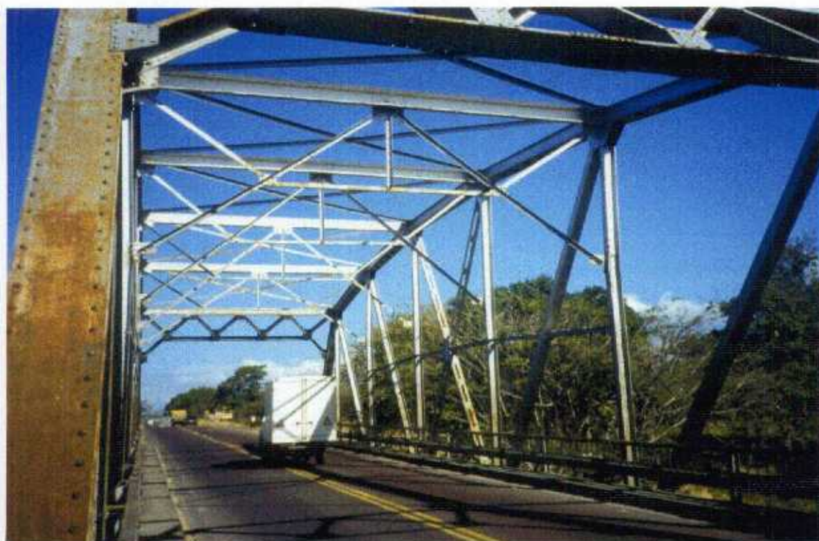
Fig. F-30: Puente sobre el Río Liberia.
