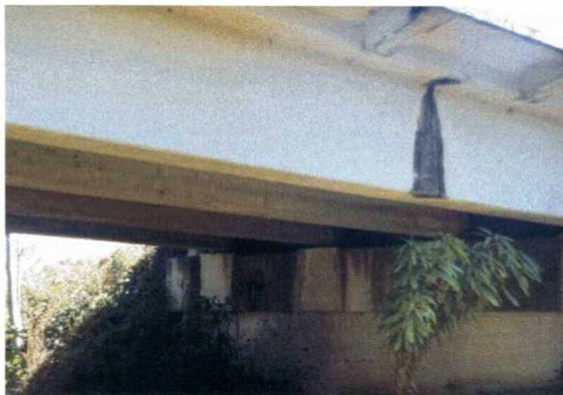
Fig. F-28: Puente sobre el Río Pijje.
