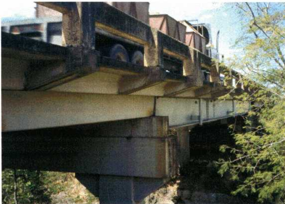
Fig. F-25: Puente sobre el Río Blanco.
