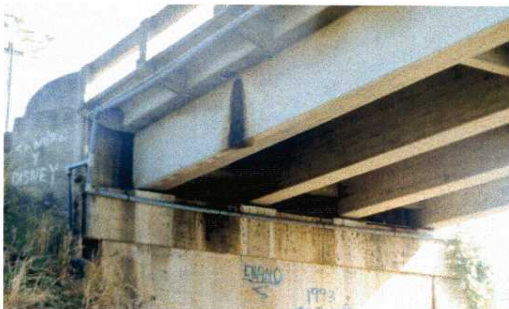
Fig F-22: Puente sobre el Río Cañas
