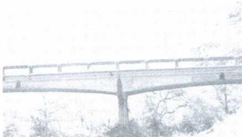
Fig F-41: Puente sobre el río En Medio.
