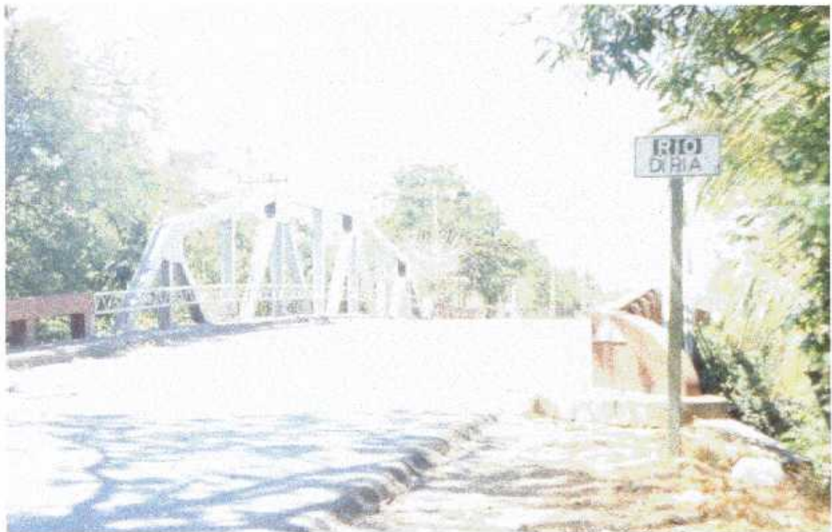
Fig F-42: Puente sobre el río Diríá
