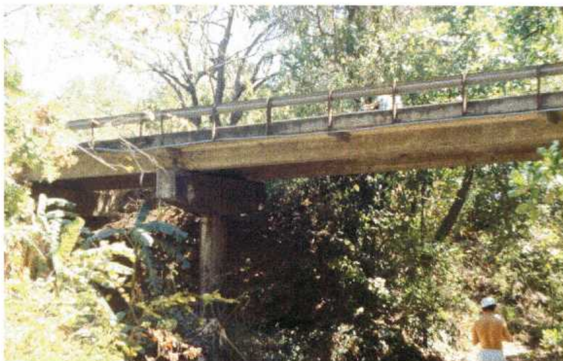
Fig F-48: Puente sobre la Quebrada Lima.
