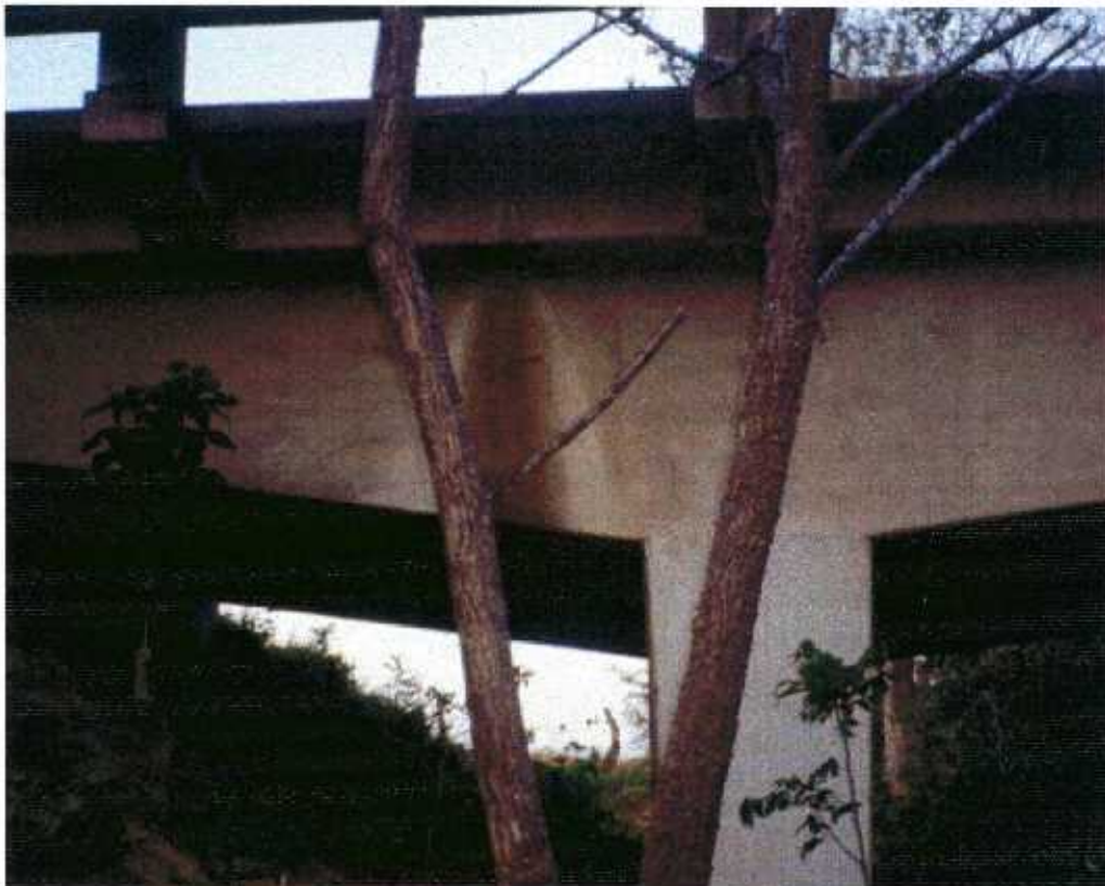
Fig F-35: Puente sobre el río Azufrado
