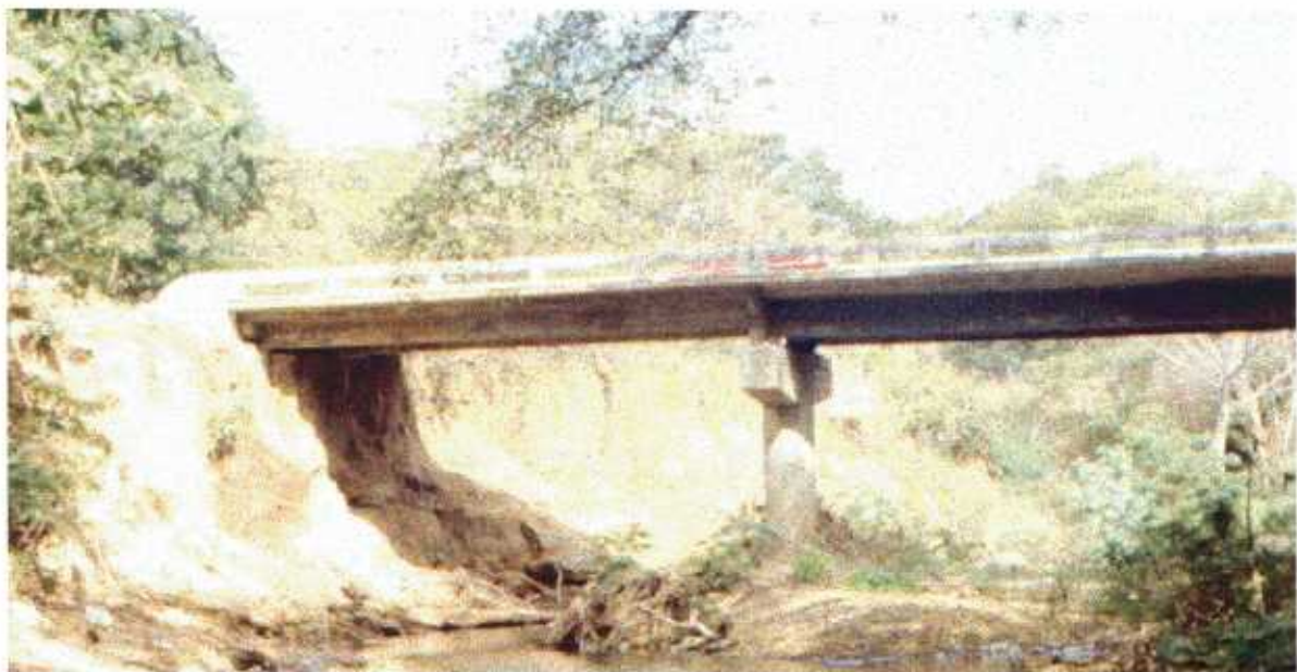
Fig F-45: Puente sobre el río Sardinal
