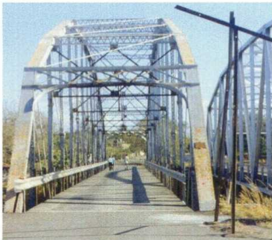
Fig F-38: Puente viejo sobre el río Tempisque.
