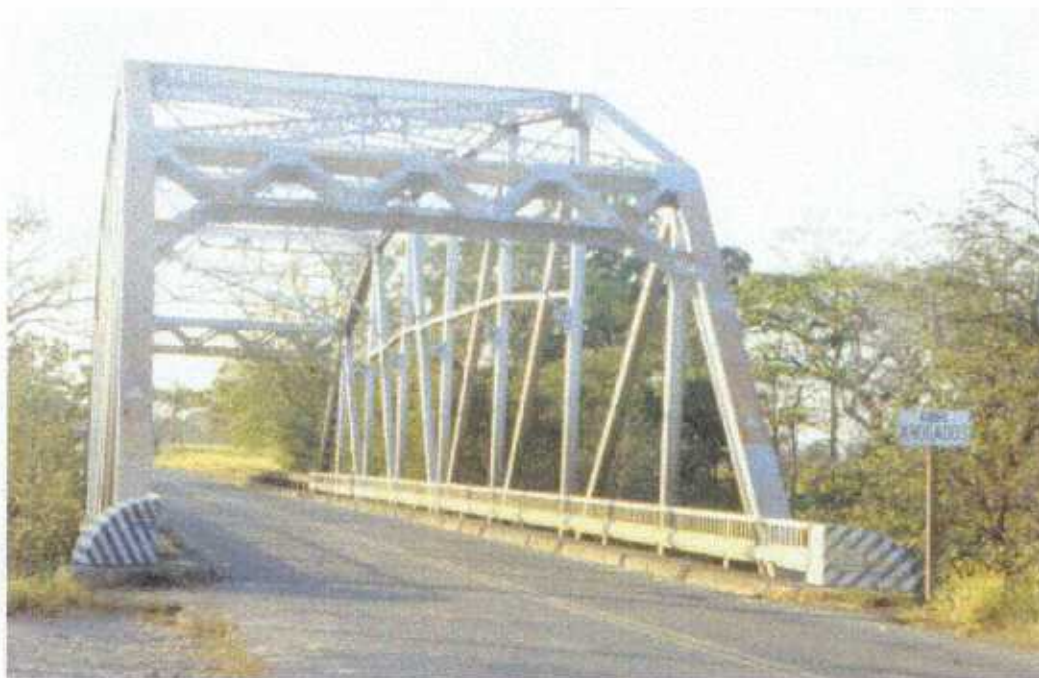
Fig F-34: Puente sobre el río Ahogados
