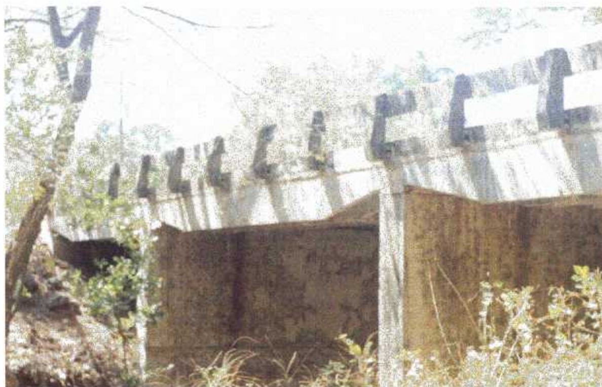
Fig F-47: Puente sobre el río Coyolito.
