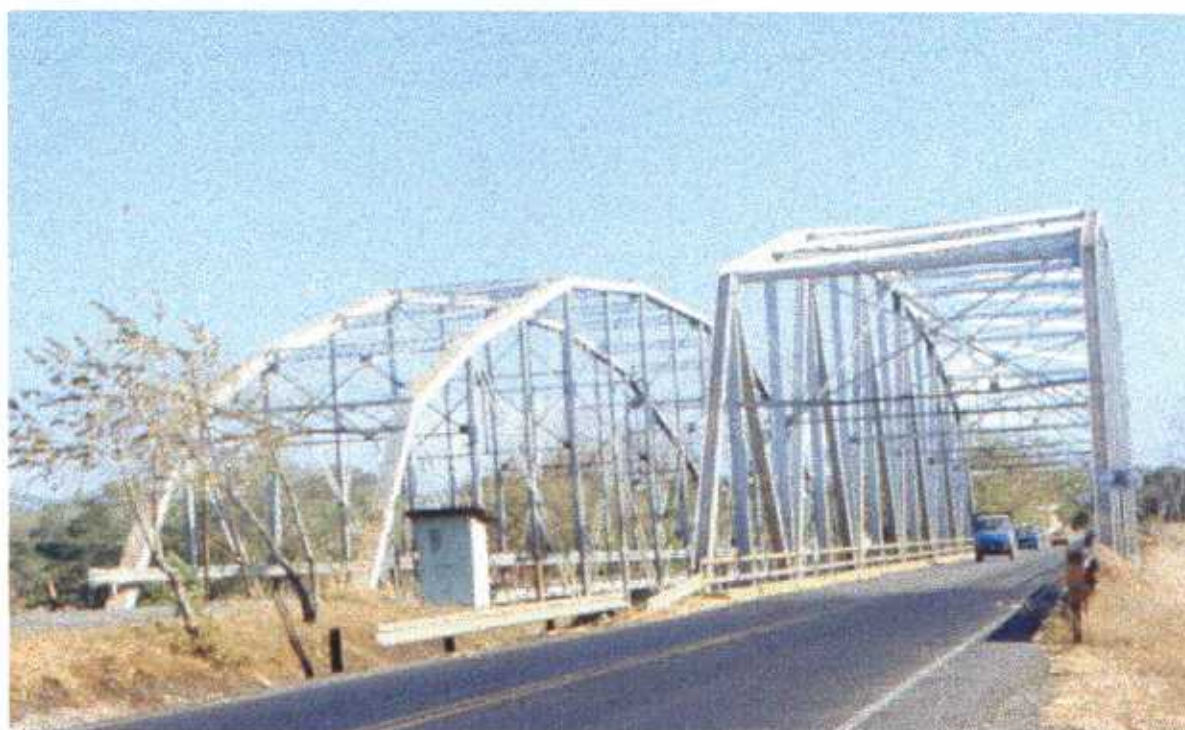
Fig F-37: Puentes sobre el río Tempisque (puente nuevo a la derecha)
