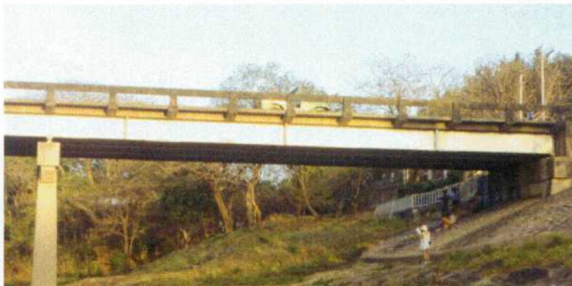
Fig F-36: Puente sobre el río Tempisquito
