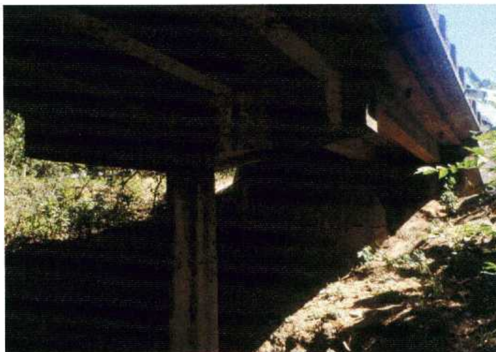
Fig F-39: Puente sobre el río Belén.
