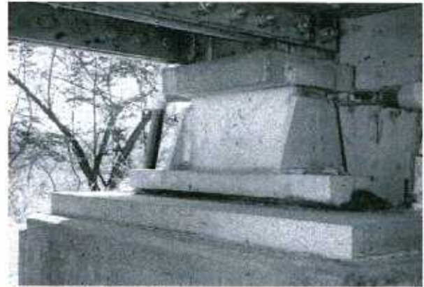
Fig. F-43: Detalle de apoyo móvil
