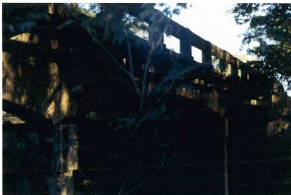
Fig F-33: Puente sobre el río Irigaray
