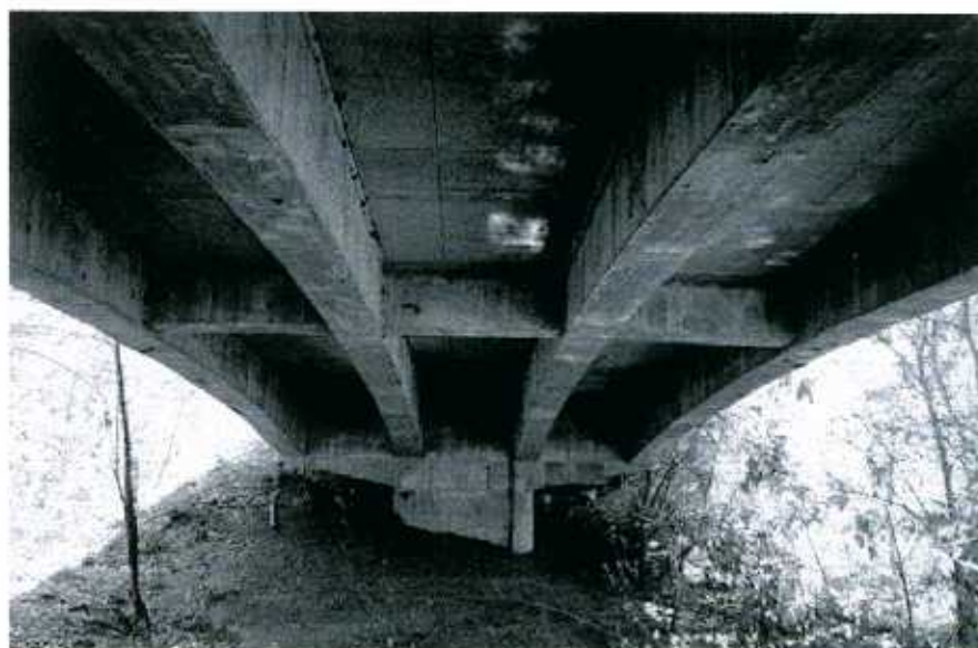
Fig. F-63: Puente sobre la Quebrada Piñuela
