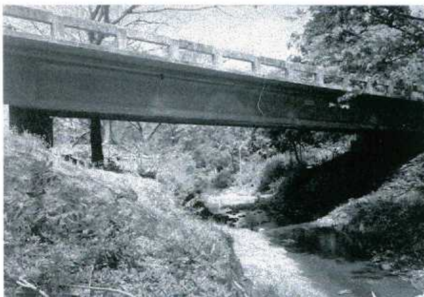
Fig. F-62: Puente sobre la Quebrada Honda
