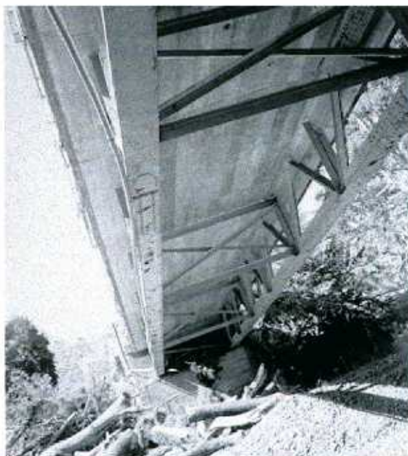
Fig. F-61: Puente sobre el Río Cecilia
