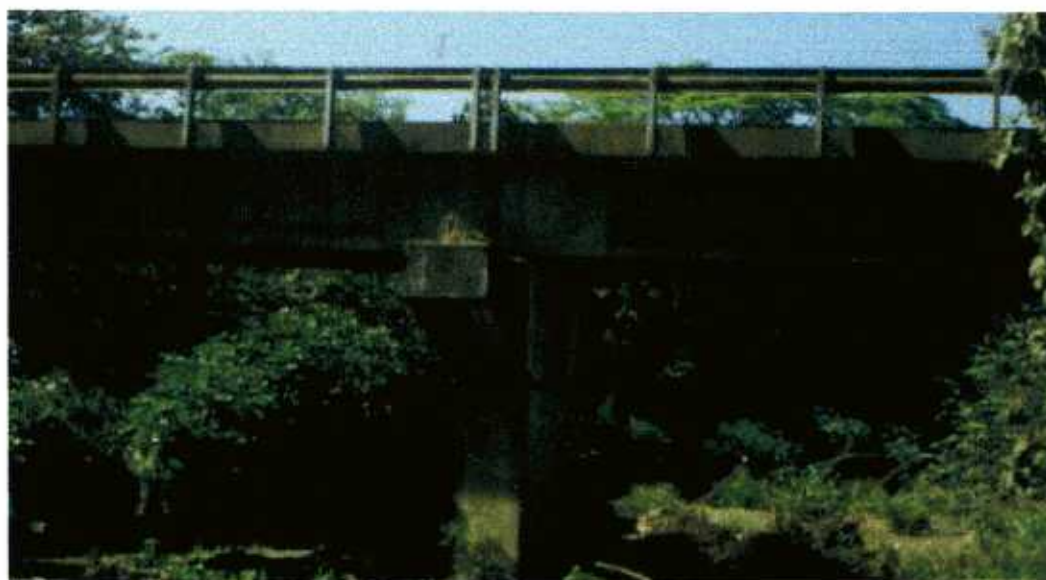
Fig F-56: Puente sobre el río Guajiniquil
