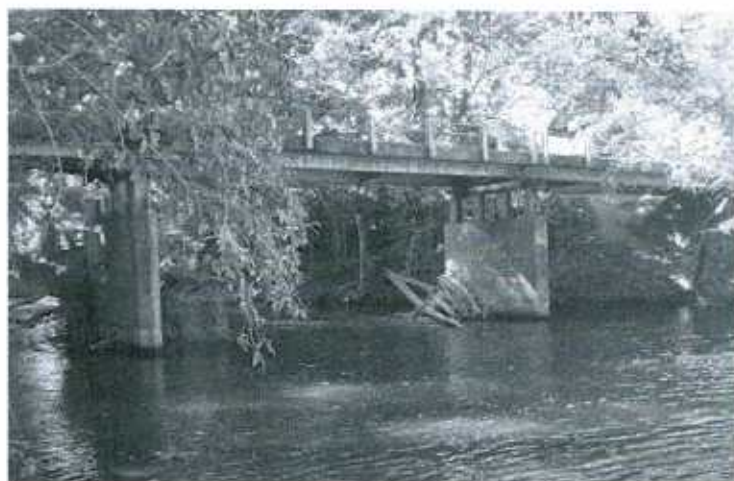
Fig. F-59: Puente sobre el Río Pánica
