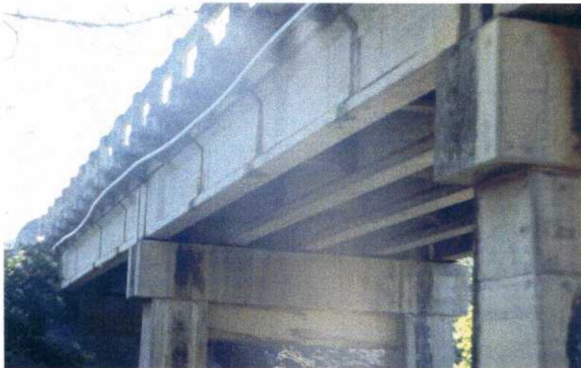
Fig F-64: Puente sobre el río Santa Rosa.
