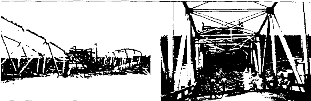
Figura 2.1: Colapso de los dos tramos principales del puente sobre el Río Estrella, durante el terremoto de 1991.
