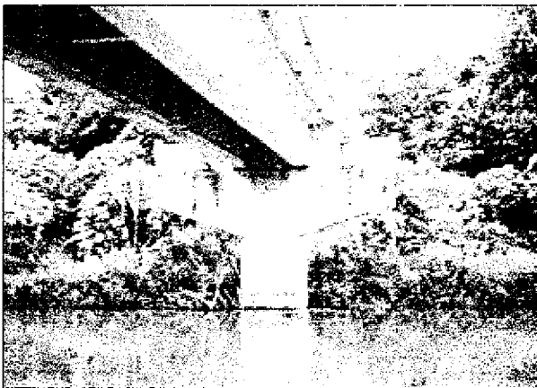
Figura 4.8 : Pila tipo cabeza de martillo.
