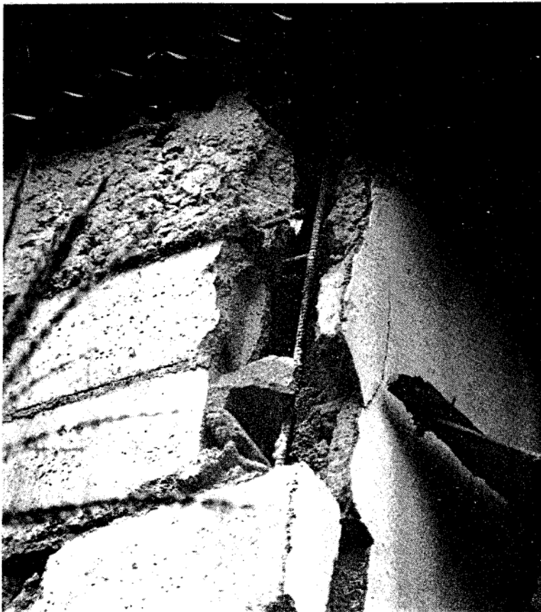
Foto 5. El refuerzo esquinero, de por sí insuficiente (solo una varilla) no soportó el sismo, puesto que como se ve, la viga corona no está empalmada para que funcione como se requiere en las esquinas. (Puriscal, 1990)
