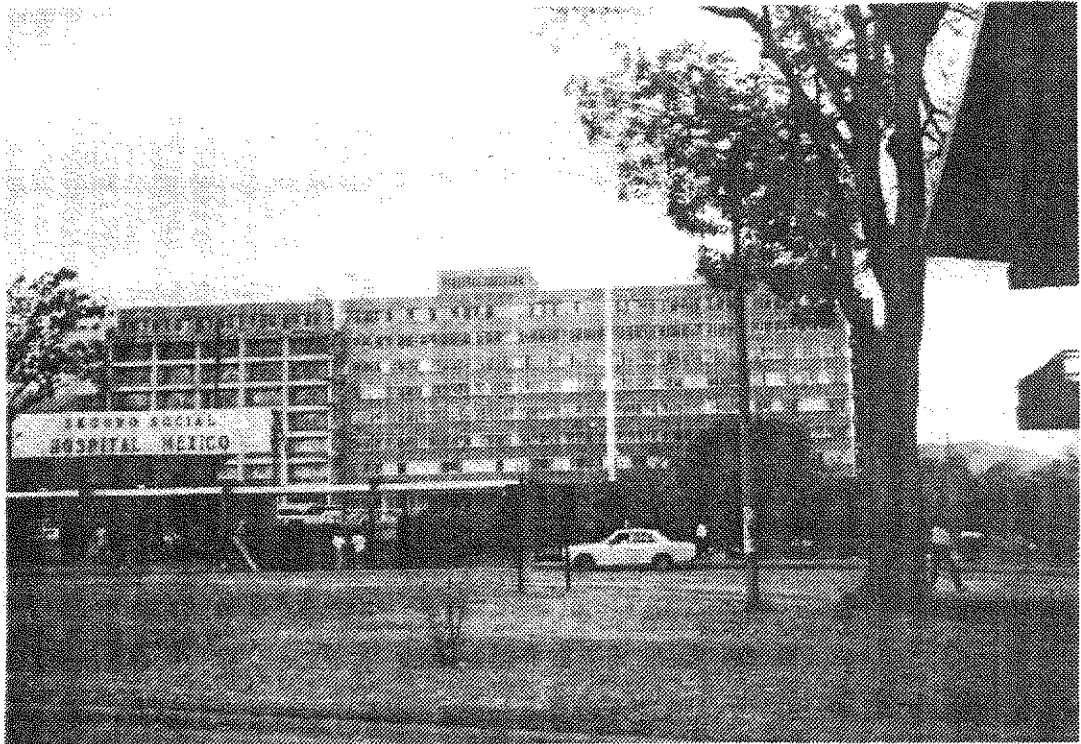
a) Fachada original en proceso de refuerzo
