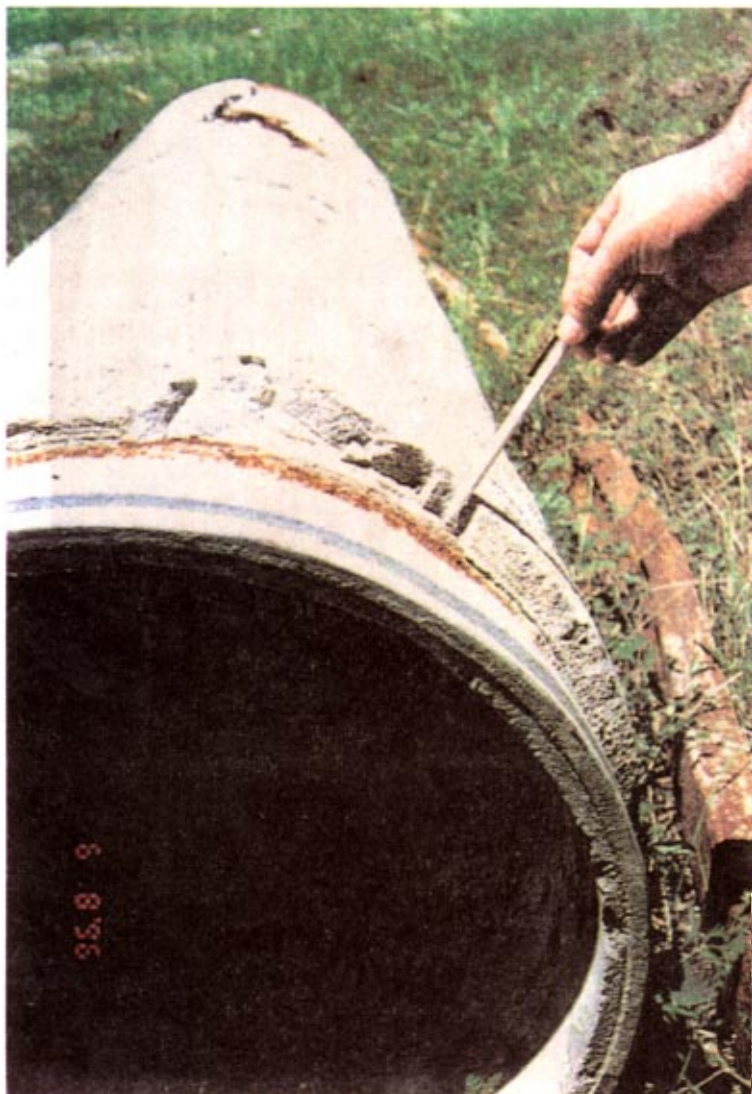
Fotografía 3.3 Detalle de la composición del tubo de concreto reforzado de 500 mm
