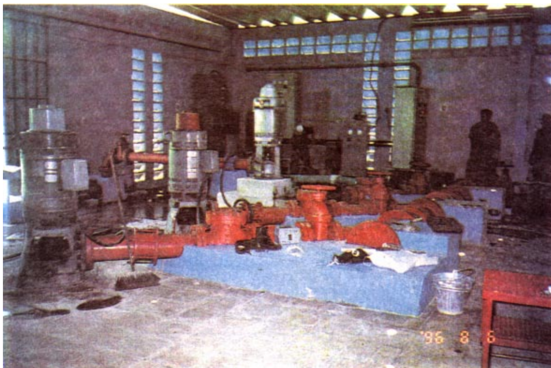
Fotografía 3.7 Estación de bombeo Moin
